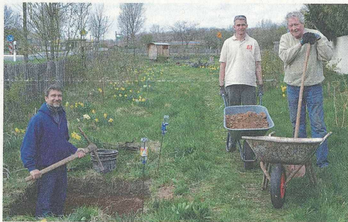
Mit Hand am Arm für das „Summstein“-Fundament: Ingo Rohrwasser, Mathias Brendle und Eckhard Hausch (v.l.).
